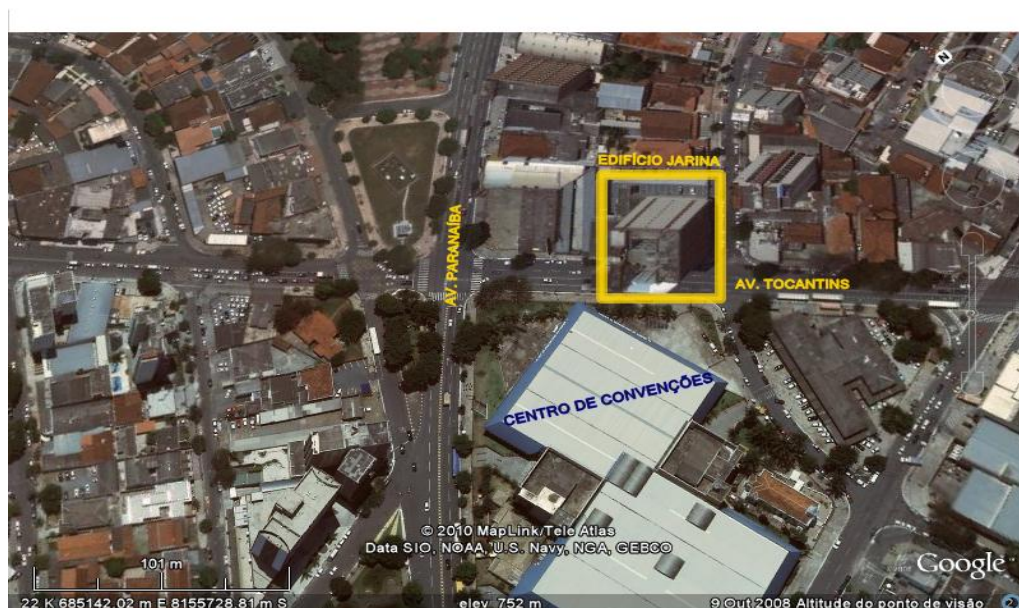
Figura 1 – Foto da localização do Edifício Jarina, Goiânia – GO. Fonte: www.googleearth.com.br
